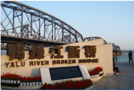
สะพานขาด
